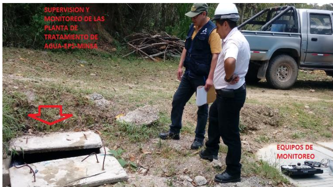
Fotografía N° 1: Reconociendo las Instalaciones de la Planta de Tratamiento de Agua Potable.
