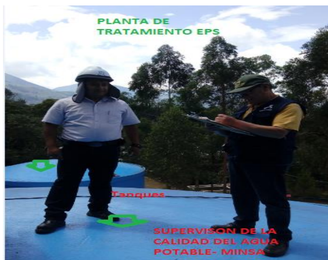
Fotografía N° 2: Reconociendo las Instalaciones de la Planta de Tratamiento de Agua Potable (reservorio).
