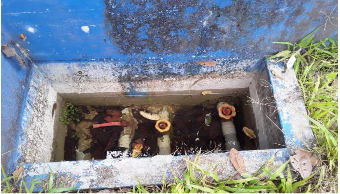
Fotografía N° 7: Antiguas Infraestructuras de Captación de agua (caja de llaves)
