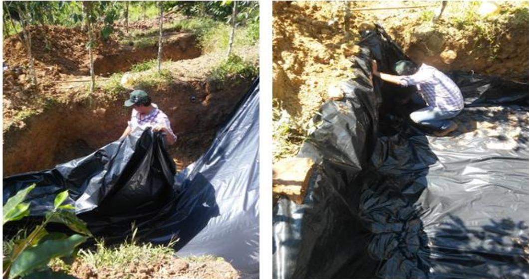
**FOTO N° 11:** Instalación del biofiltro con Jacinto acuático.
