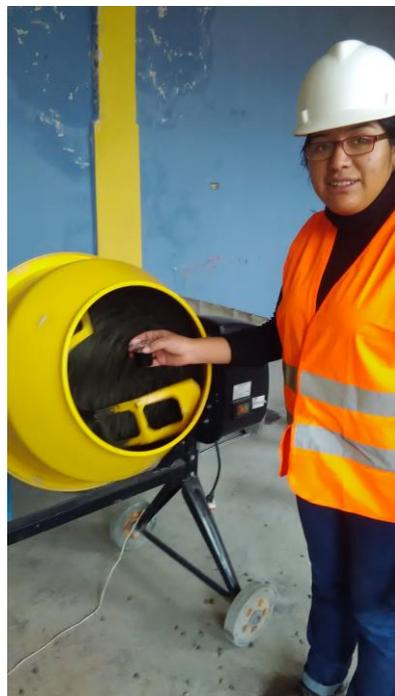
En la vista, adición del aditivo PLASTIMNET a la mezcla.
