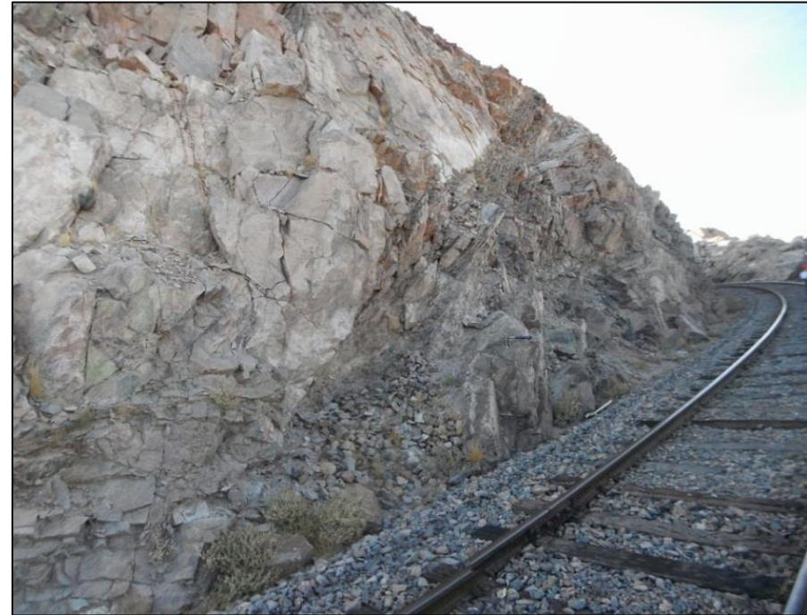
**Foto 15.-** Falla inversa adyacente vía férrea, ubicada en coordenadas UTM, WGS84 E 210420 y N 8182960, con relleno de
