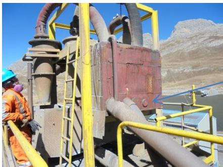
Los cajones presentan deterioro y corrosión requiere ser cambiado.
