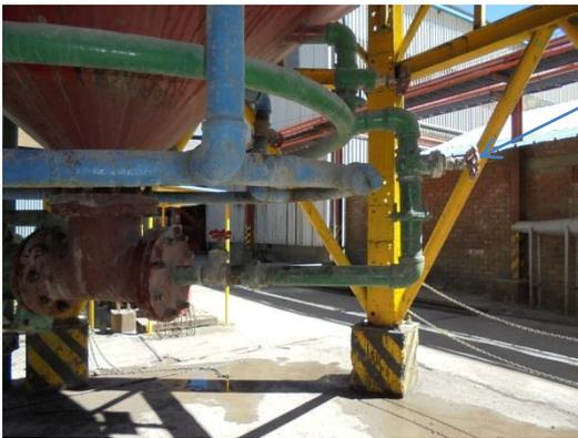
Las válvulas de agua y aire de inyección a los Silos presentan desgaste, y fugas, el cual hace que no se pueda controlar.
