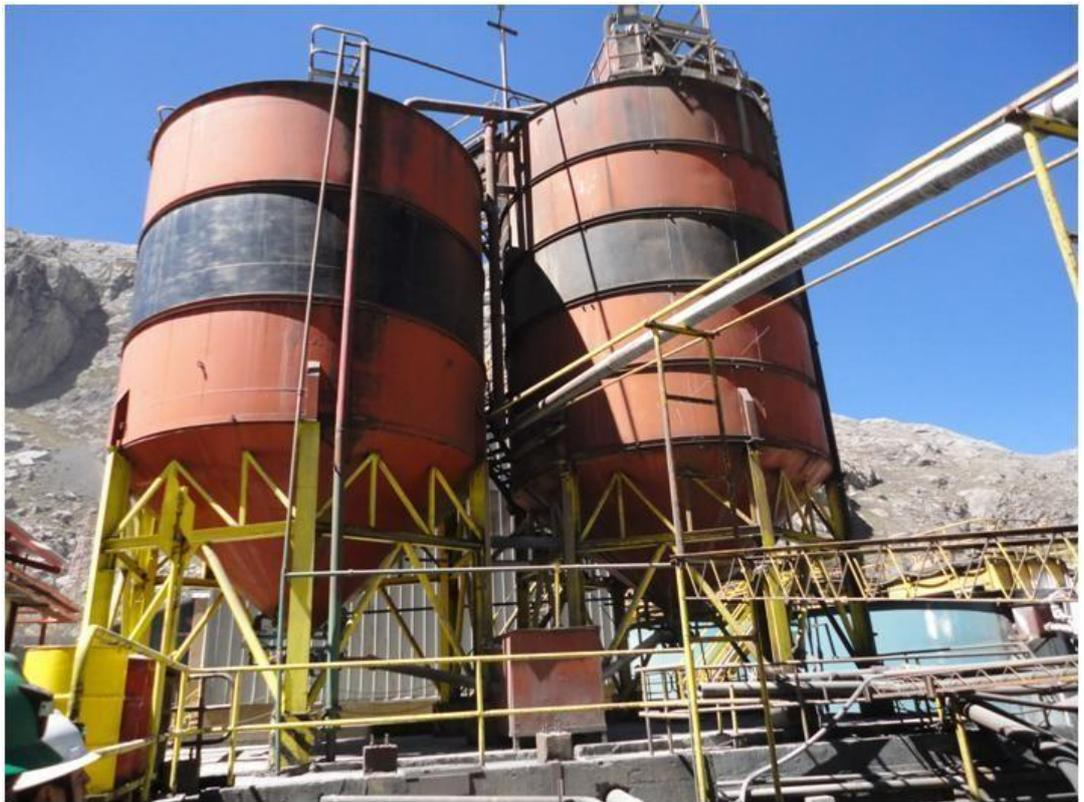
*Ilustración 8. Tanques de almacenamiento de Relave clasificado para RH*
