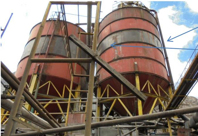
El Silo N° 02, presenta desgaste por corrosión, requiere una evaluación, para su reparación y/o cambio.
