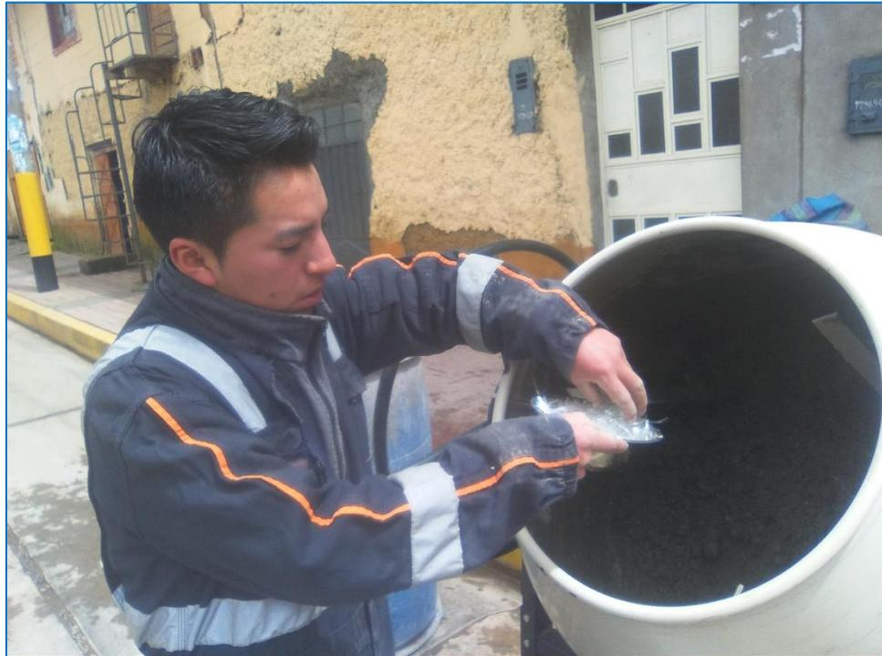
*En la vista, la adición de las fibras de polietileno a la mezcla.*
